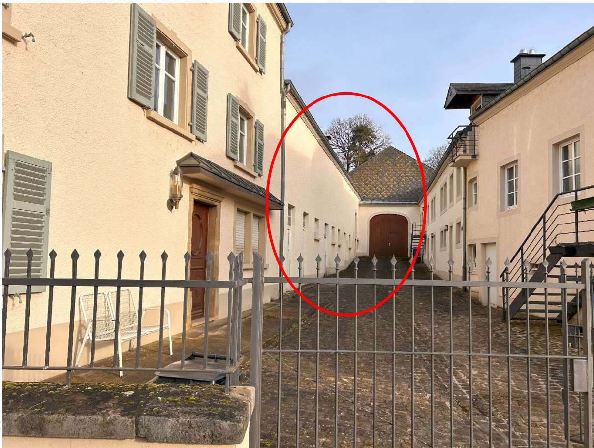
Abbildung 20: Blick auf die bestehenden Gebäude innerhalb des Plangebiets. Der Schutzstatus der eingekreisten Gebäude soll angepasst werden, in diesem Bereich sind die Eingänge der Häuser geplant (siehe Planunterlagen - Jonas Architectes Associés, 2022). Quelle: Oeko-Bureau, Februar 2024.
