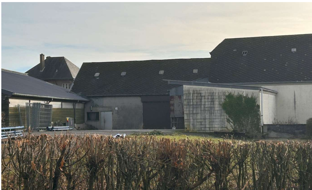
Abbildung 15: Blick aus westlicher Richtung auf das östliche Plangebiet und Gebäude, deren Schutzstatus angepasst werden soll (mittig und rechts). Quelle: Oeko-Bureau, Februar 2024.
