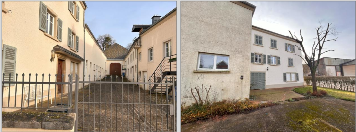
Abbildung 3: kommunal geschütztes Gebäude an der „Rue de la Fail“. Quelle: Oeko-Bureau 2024
