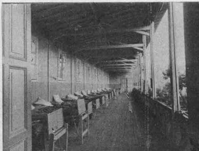
Intérieur de la galerie de cure d'Air
