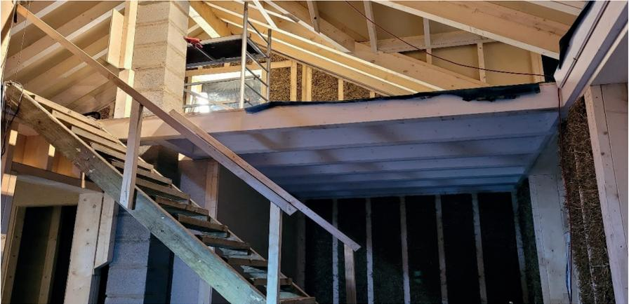
Das 2001 mit Betonsteinen und „Styropor“-Dämmung konventionell gebaute Haus wurde mit einer strohausgefachten Holzständerkonstruktion ab dem 1. OG aufgestockt. Alle Außenwände (Betonstein und Strohkonstruktion) sind mit Holzfaserplatten gedämmt und einer Kalkputz-Fassade versehen. Dazu wurden alle Fenster durch Holzfenster erneuert und als sommerlicher Wärmeschutz auf der Sonnenseite mit Jalousien ergänzt.
