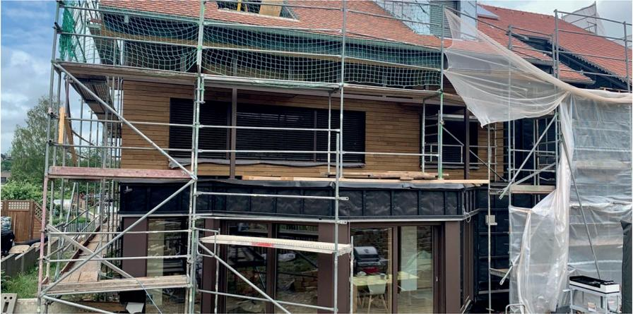
Auf die leimfreien Massivholz-Außenwände wurde eine Holzfaserdämmung und eine Fassadenbekleidung aus Thermo-Weisstanne aufgebracht. Die Innenwände sind teils in Holz-Optik belassen und teils mit Lehm verputzt. Auf die Massivholzdecken wurden ein Trockenbodenaufbau erstellt von 8 cm Kalksplitt (ungebunden) + 2 cm Holzfaserdämmplatte + 2 x Phonostar Platten wegen Schallschutz (kartonummantelte Quarzsandplatten) + 4 cm Holzfaserdämmplatten mit Holzlatten zum Anschrauben der Holzdielen.
